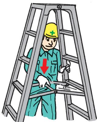
図3-19 開き止めのロックの例
