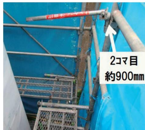
図2-18 段差のある作業床の端部にストッパーを取付けた例
