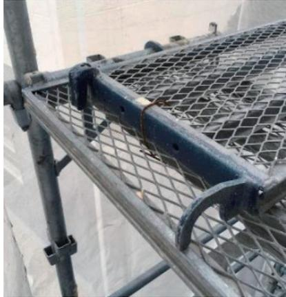
図2-16 不安定な作業床を番線で固定
