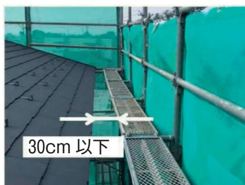
図2-15 軒先と建地の間に作業床を設置して離れが30cm以下となるように措置した例
