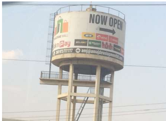
ジョージ地区のコンクリート製高架水槽
