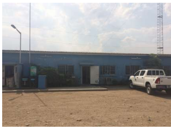
日本の支援で建設された LWSC ジョージ事務所
