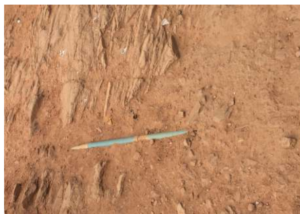
SOS 地区の岩盤に布設された PVC 管
