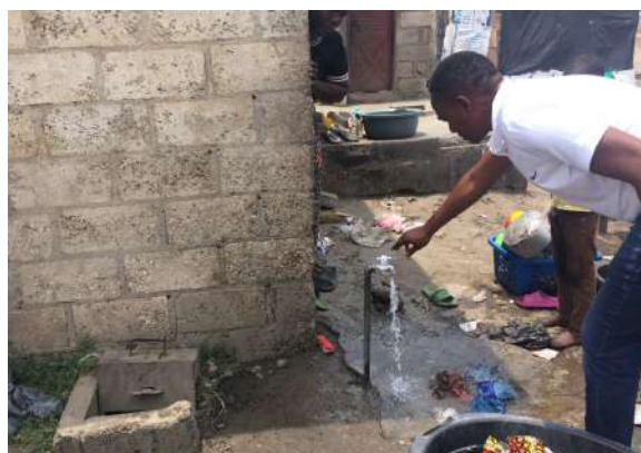
カニヤマ地区のヤードタップ
