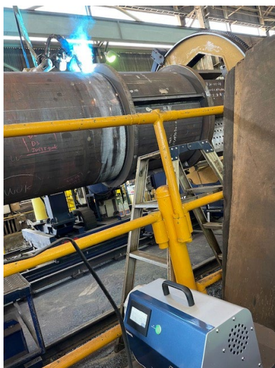
図 1. 溶接工場における PM2.5 採取の様子
