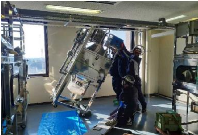
図3 吸入曝露チャンバー撤去作業
