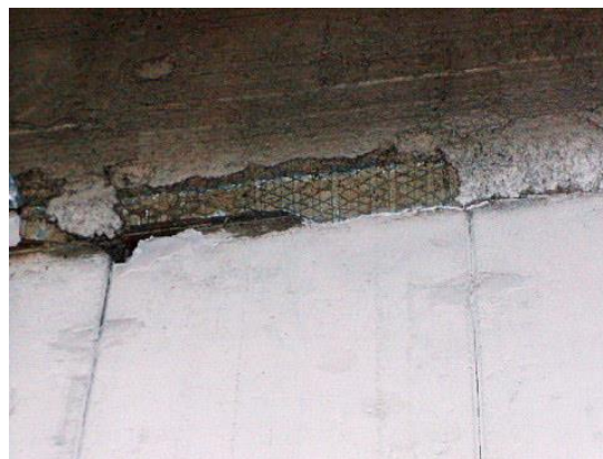
（劣化）壁・天井取り合い部。ラス下地の暴れに伴う脱落
