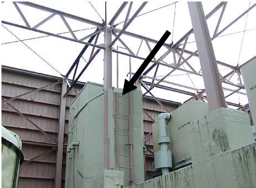
PH2の上+4mが煙突トップ。タラップ・避雷針あり、陣笠なし。 カポスタック・内径832φ×50t×54.8m
