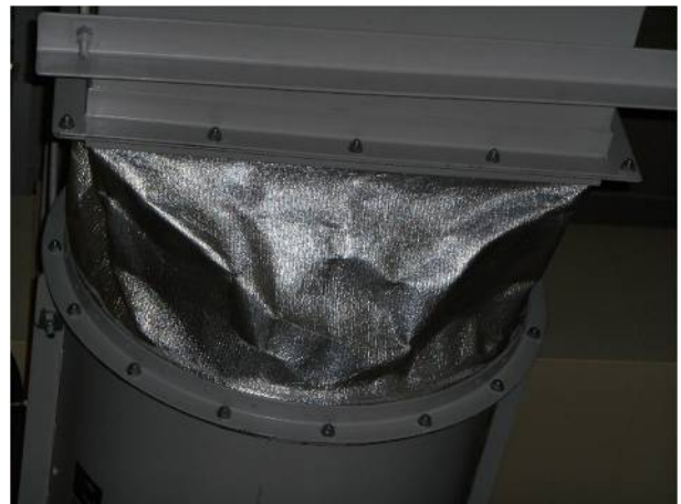
キャンバス継手アルミ箔
