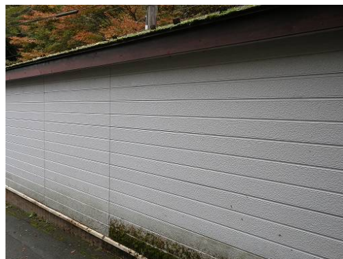
壁（裏打材に石綿含有成形板を使用）
