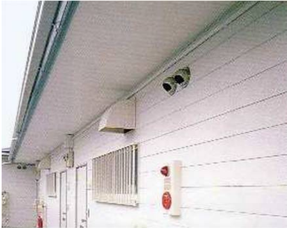
図2.37 石綿含有窯業系サイディングの施工例
