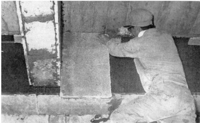
図 2.10 石綿耐火被覆板施工状況
