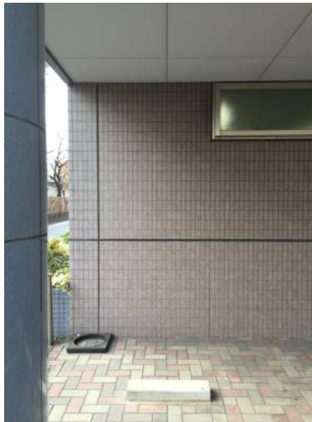
図 2.30 複合パネルの施工例
