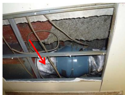
写真左：点検口の調査でダクトのパッキンが確認された。 写真右：天井板を取り外し、吹付け耐火被覆とダクトのたわみ継ぎ手が確認された。
