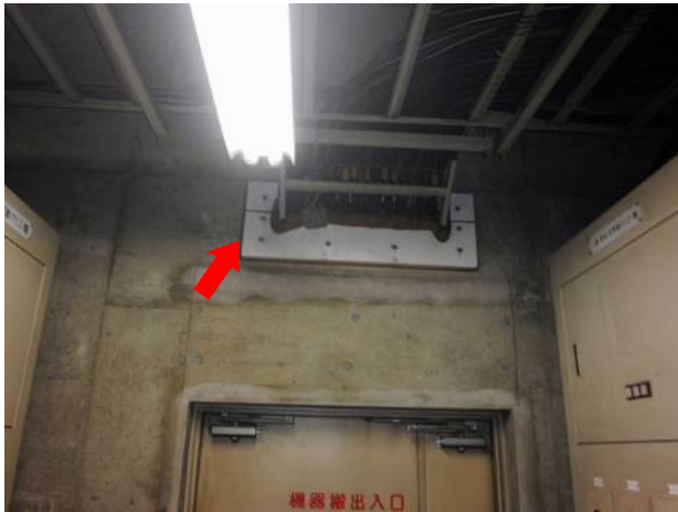
図 2. 99 壁や床のケーブル貫通部の処理（けい酸カルシウム板第２種）
