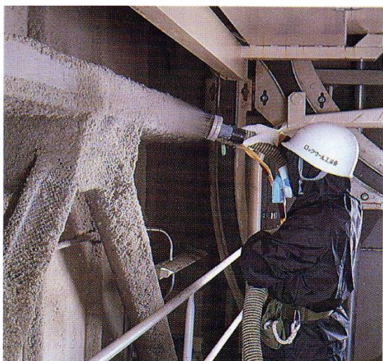
図 2.8 半乾式吹付け施工と機械
