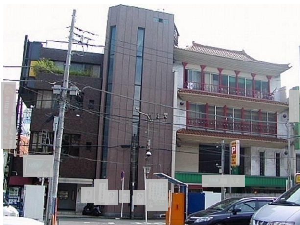
正面側 右（店舗）と左（事務所）がRC造、 中央が増築S造に見える複雑な例
