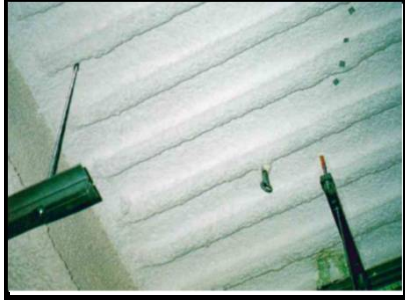
c)現場吹付け無機不燃材 (ダンセラボン)
