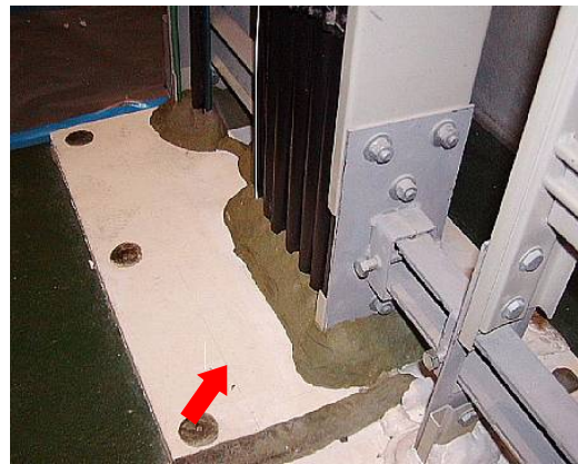
図 2. 99 壁や床のケーブル貫通部の処理（けい酸カルシウム板第２種）
