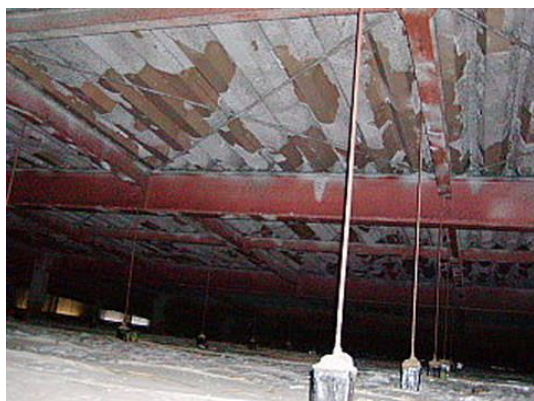
（劣化）折板屋根。気温や風圧による折板屋根の収縮や振動での脱落
