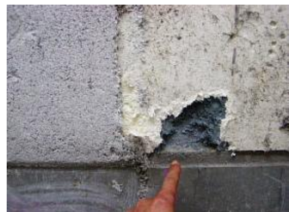
吹付け石綿（クロシドライト）にクリソタイルの2層吹き（旧工事）、この上に石綿不含有の吹付けロックウール
