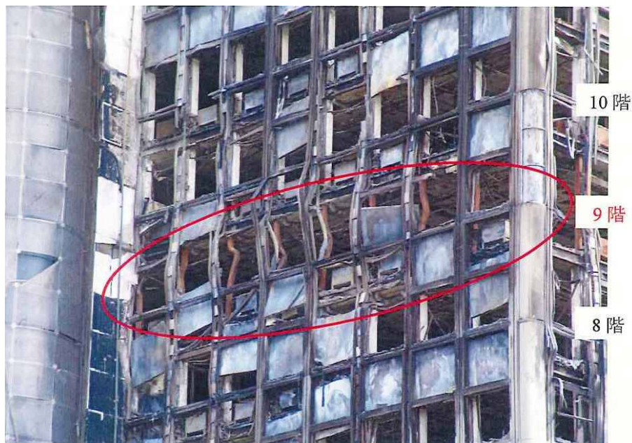
図 2.67 9階の耐火被覆の無いS造柱（撮影：宮本圭一（調査団））
