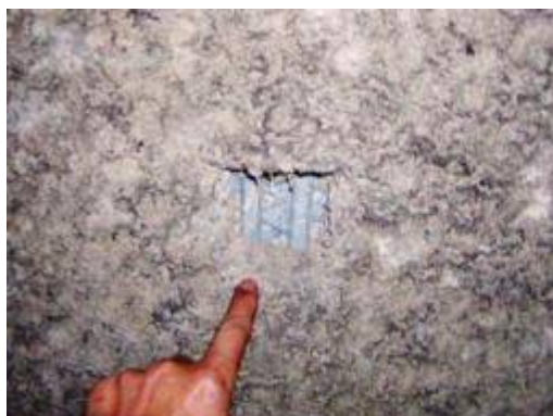
リプラス下地の吹付け RW、写真掲載ページに余裕があれば、組写真とした方がよい場合もある 階段室の防火区画で左壁のブロック上にラス網
