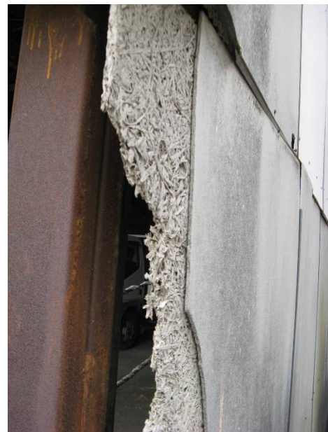
図 2.29 複合ボードの施工例
