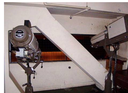
調光室など。筋交い（ブレース）に耐火被覆板が使用されている
