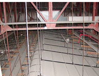
客席の天井裏。左に歩廊、トラス状の大梁には吹付け石綿などあり
