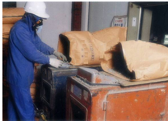
図 2.7 乾式吹付け施工と機械
