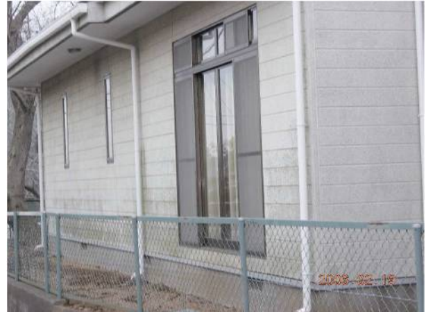
図2.37 石綿含有窯業系サイディングの施工例
