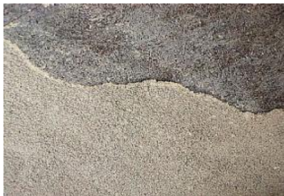
木毛セメント板（上）下地の浮いた吹付け石綿（下）の界面はく離
