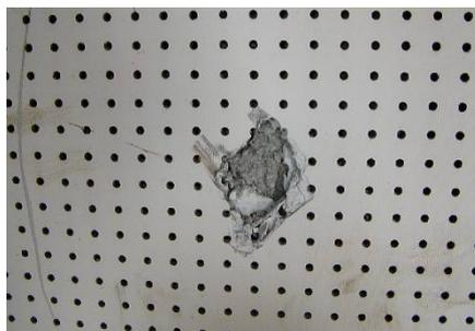
音響調整室など。有孔ケイ酸カルシウム板の内側に吹付け石綿などあり
