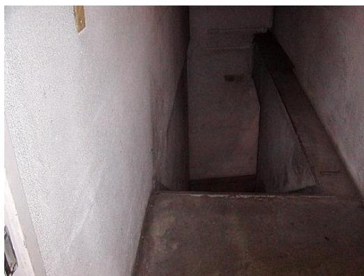
㉒ B1F D階段 天井・壁はRC打放しで吹付け材はなし
