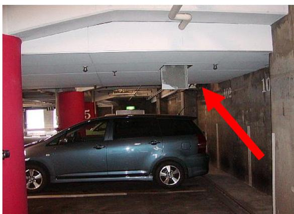
3F駐車場 西側一部天井貼り部(改修履歴有り)、その他はRCスラブ(石綿除去歴あり・飛散防止剤の薬液不明)
