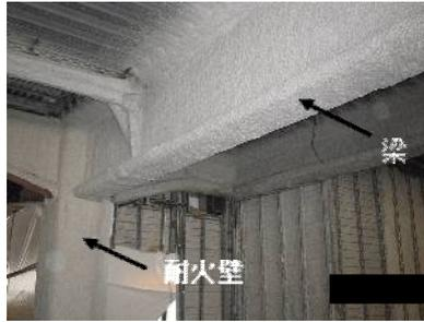
湿式耐火間仕切り壁(右)と柱、はりへの湿式吹付けロックウールの施工例
