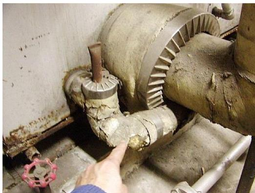
⑯ 機械室A・B共に配管エルボ部の損傷は顕著なものも複数ある
