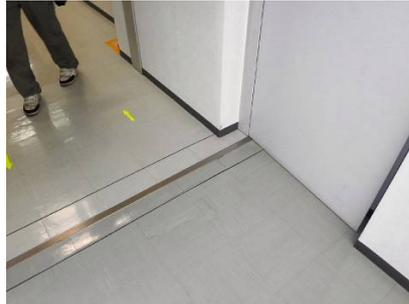
増築建物との接続部（エキスパンションジョイント）の裏側にも吹付けや耐火帯が施工されていることが多いが取り外し確認は非常に困難である
