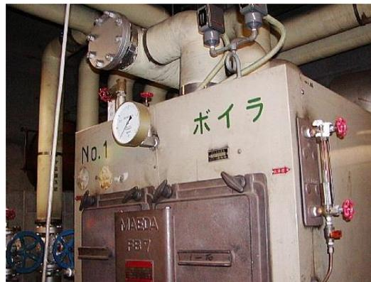
⑩ 1号ボイラー(ボイラー本体内部の断熱材は使用中のため未確認)
