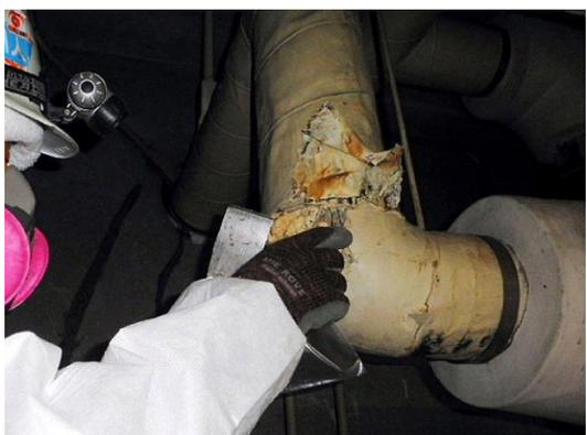
⑮ 機械室A 温水戻り管(表面被幕材の損傷は大)
