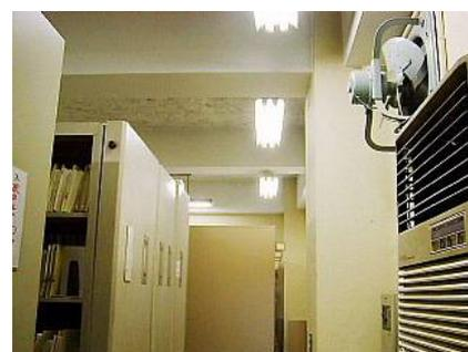
カルテ室—書類の保管環境に配慮する意図などで、天井に調湿目的の吹付け石綿が施工されている
