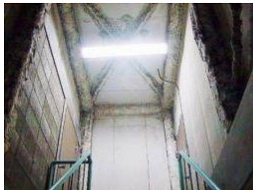
リプラス下地の吹付けRW、写真掲載ページに余裕があれば、組写真とした方がよい場合もある
