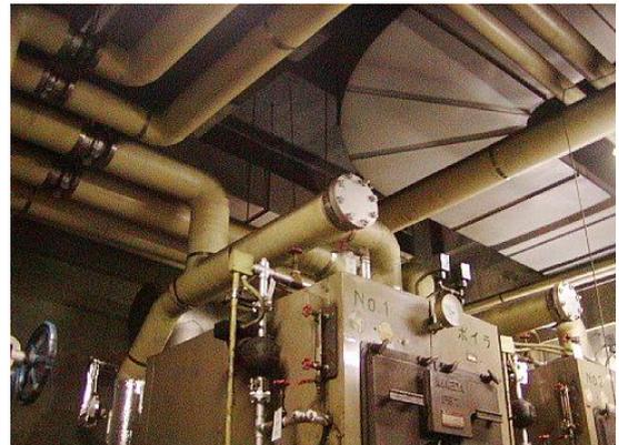
② ボイラー室。天井に吹付けRW(乾式・半乾式)の確認(CH=5,100)
