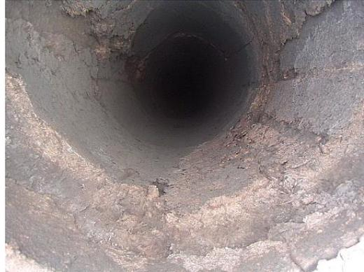
トップより煙突内部の見下ろし撮影。トップから1.5m下まで劣化している。
