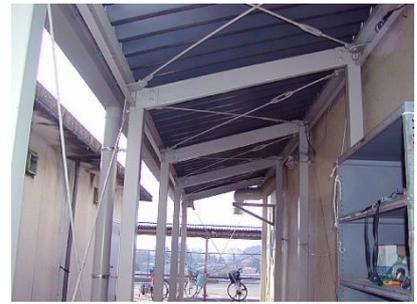
渡り廊下は壁などは設置されておらず、スレート屋根や折板屋根による施工が多い
