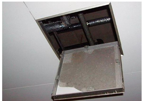
同左 点検口開放(矢印部)、石綿除去後に設備改修され、その配管を隠すために天井を貼ったものと思われる
