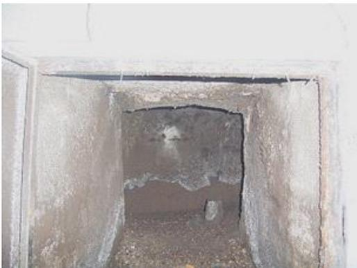
最下部に堆積物(繊維状物質を目視確認)で排水ピットが埋まっている。点検口から煙突まで600mm
