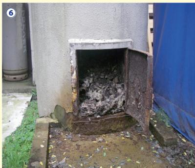
⑥ 点検口に剥落堆積や堆積履歴がある。
