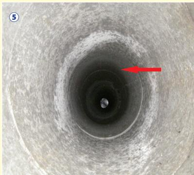
⑤ 一見良好だが、横引き煙道の排気口接続部分（黒色部）に脱落がある。
