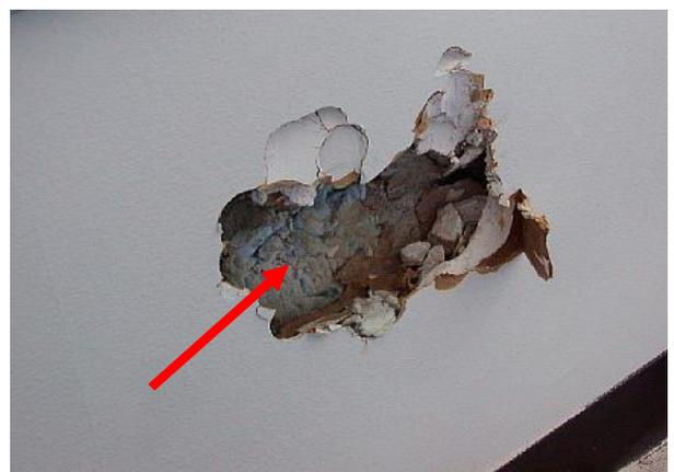
上図矢印位置の腰壁を破壊開放。ウレタン吹付けあり(不採取)
