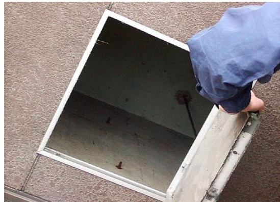
同左。軒天井裏に断熱材はナシ。軒天井板は石綿セメント板下地、ボンタイル調の塗装(不採取)。
