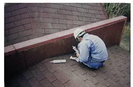
住宅屋根用化粧スレート板。調査ではこのような屋根には、体重でひびが入るなどして後日の雨漏りの原因となるリスクがあるので乗らない
