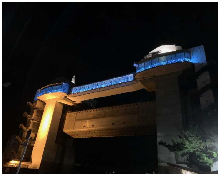
沼津港水門展望施設「ぴゅうお」 (静岡県沼津市)
