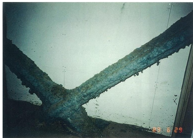
吹付材(耐火被覆)
