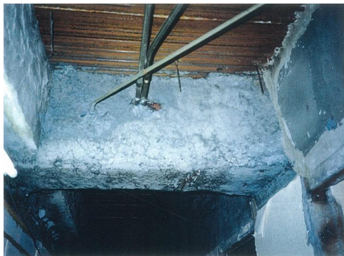
吹付材(耐火被覆)
