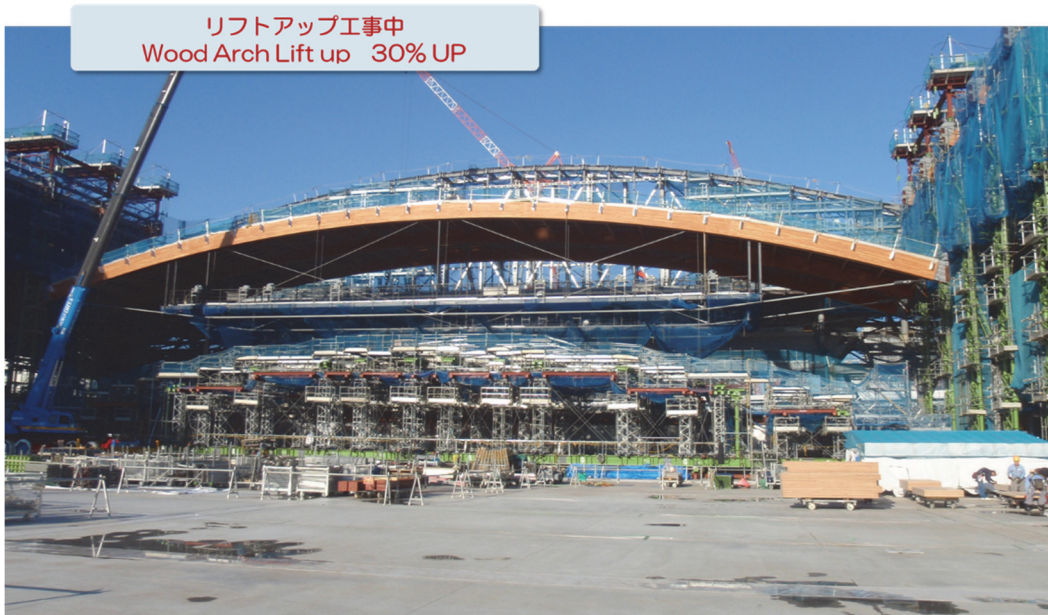
リフトアップ計画 Wood Arch Lift up
