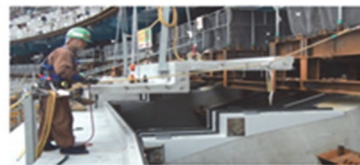
二段一体型PCa 設置状況
