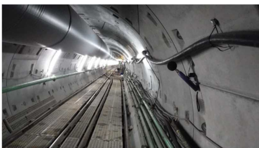
写真：トンネル内レール敷設状況
