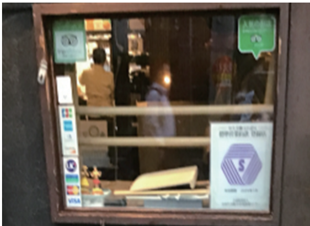
工事前の窓外観
