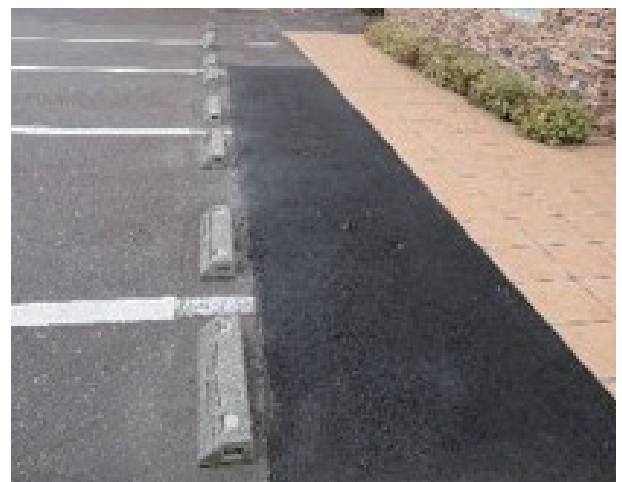
修繕後の店舗入口近く
