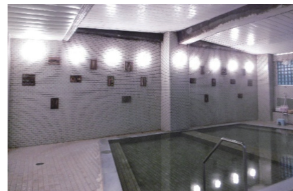
LED照明に交換した大浴場
