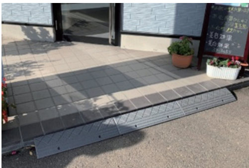
車椅子利用者のために段差解消プレートを設置
