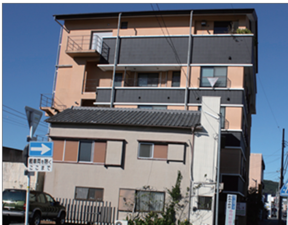
以前の旅館外観（駅方面からみて旅館名がわからない）
