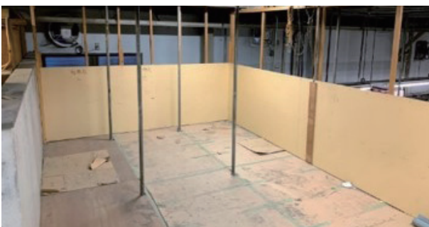
不要物が撤去された工場内
