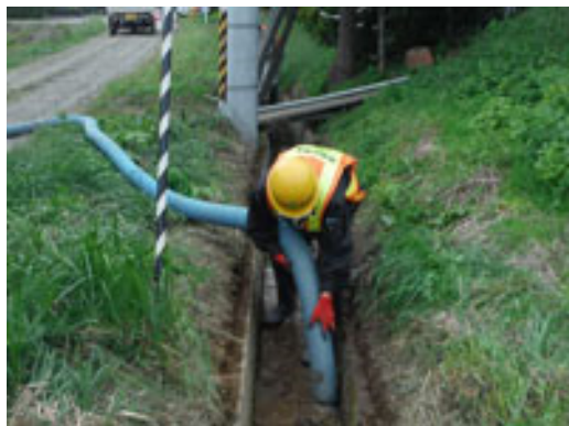
図 6 側溝の除染の例
