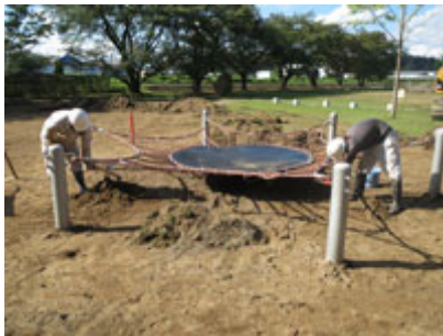
図2 面的除染の例（公園の除染）
