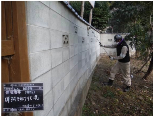
図8 コンクリートブロック塀の除染の例 [10]
