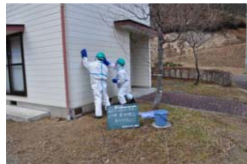
図 7 住宅壁面の除染の例 [11]
