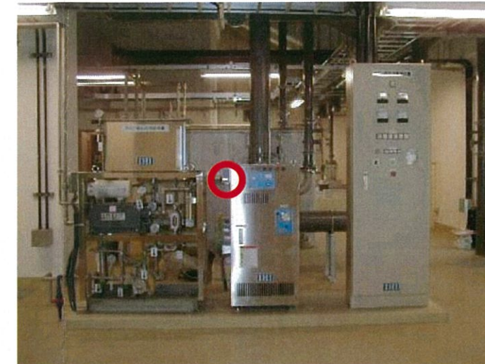
オゾンセンサー取付高さ : 床上約1m、オゾン発生器の横
