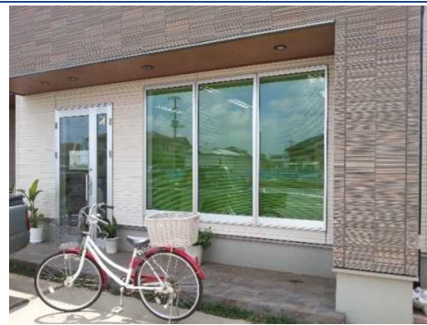
（富里ジョブサポート-ト外観）
