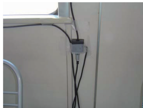
ループアンテナジョイント部分
