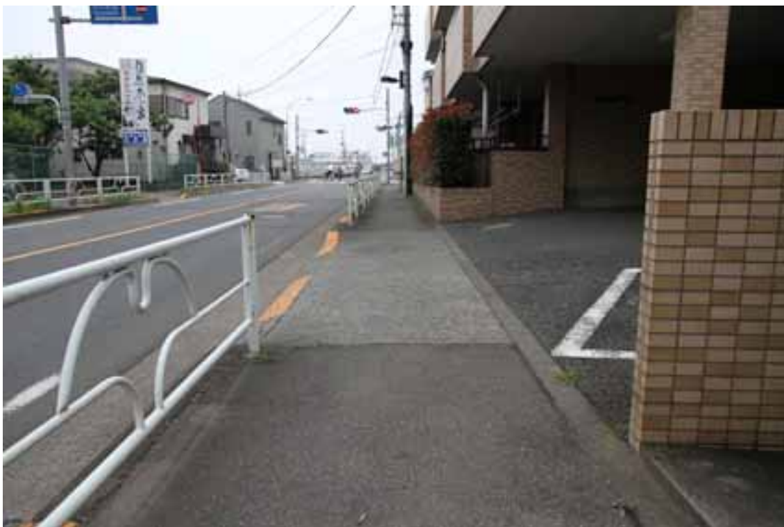
3 2 アパート駐車場入口 平均斜度 4.2° 手前 1 m程度で停止しデータ分割
