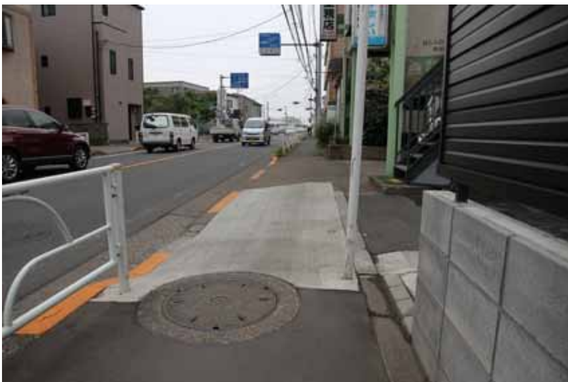
3 1 工務店前 平均斜度 7.8° 手前 1 m 程度で停止しデータ分割
