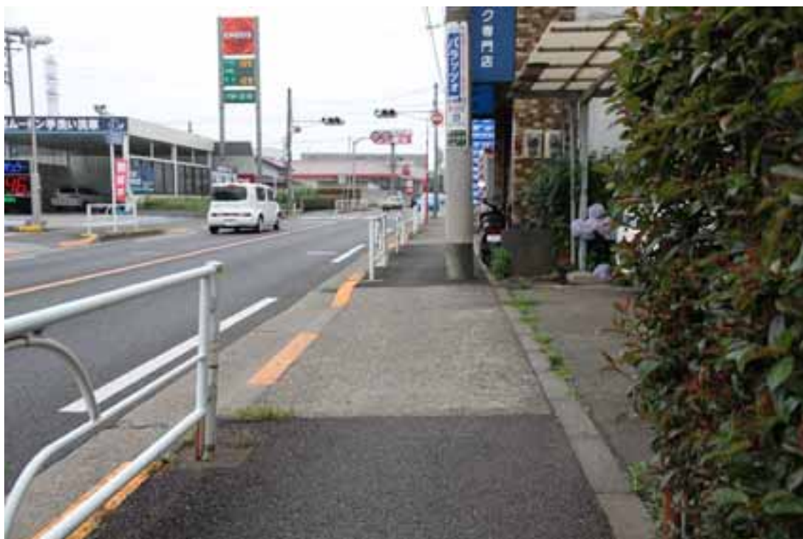
15 バイク専門店手前駐車場入口 平均斜度 7.6° 手前1m程度で停止しデータ分割18番まで連続してデータ取得
