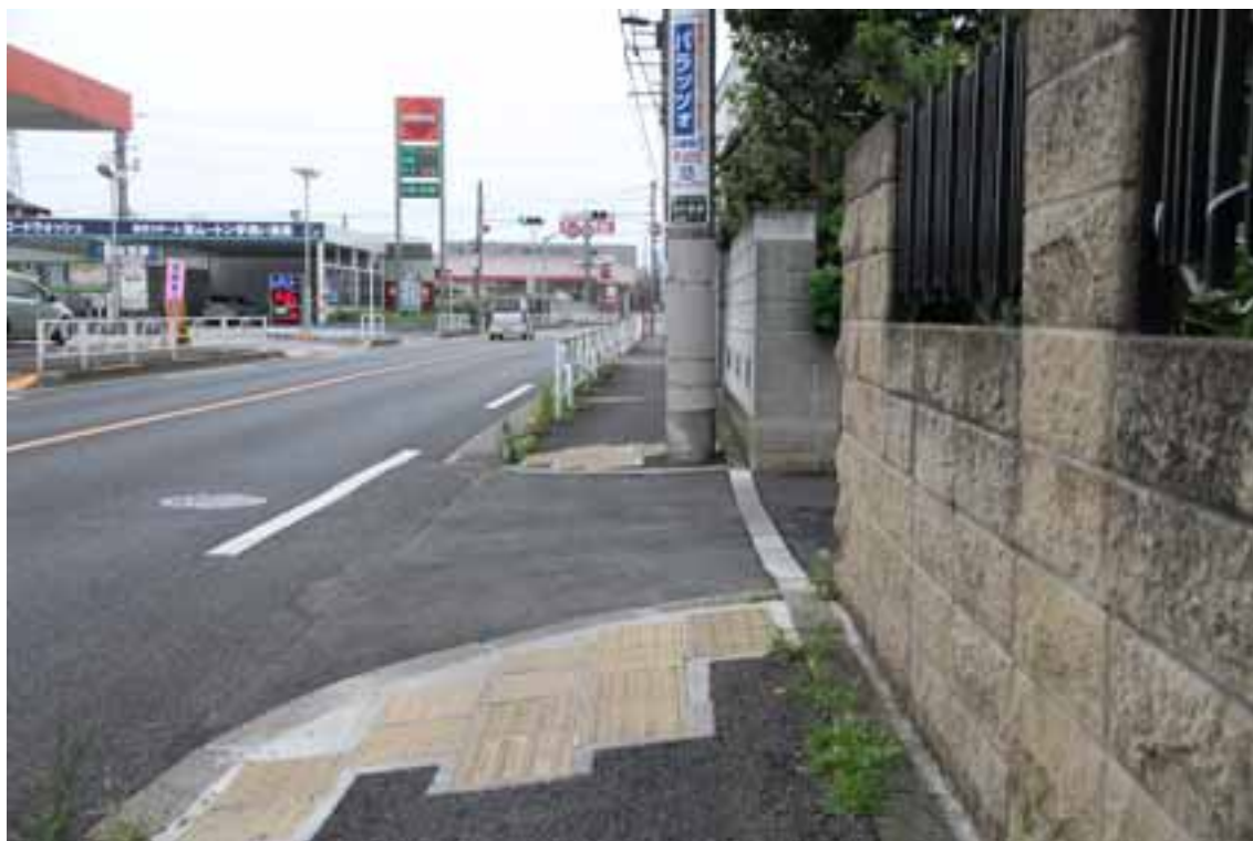
14 エネオス手前交差点 平均斜度 4.3° 12番から14番まで連続してデータ取得
