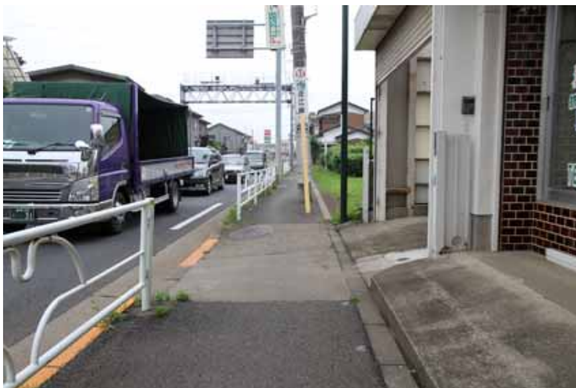
8 クリーニング店車庫入り口 平均斜度 5.6° 手前 1 m程度で停止しデータ分割
