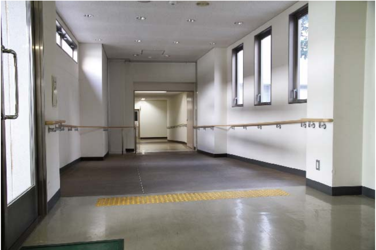
39 屋内の下りスロープ 手前の最大傾斜 3.5° 奥側の最大傾斜 5.0°
