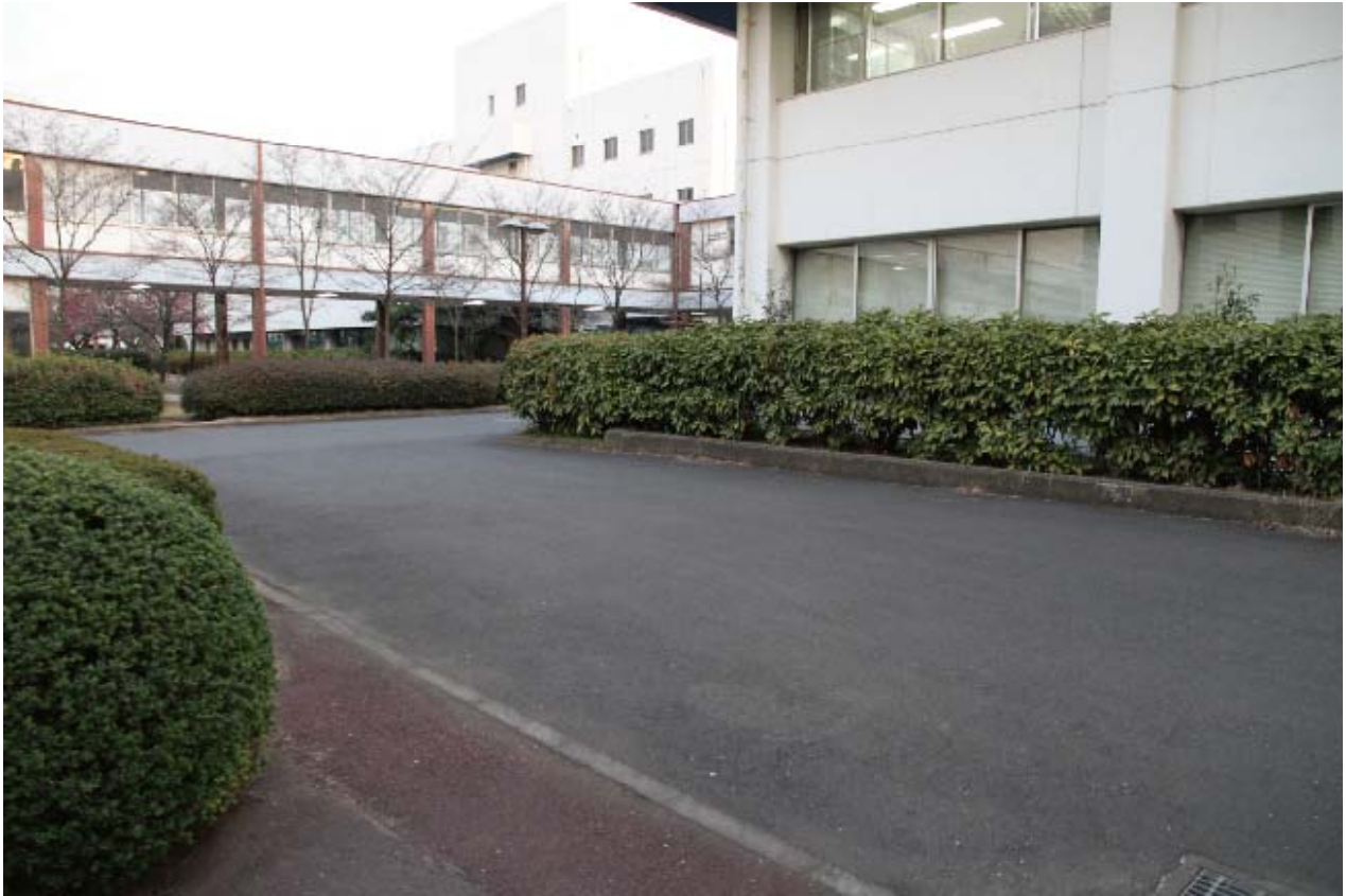
④ 停止・データ分割場所(36の段差通過後)
