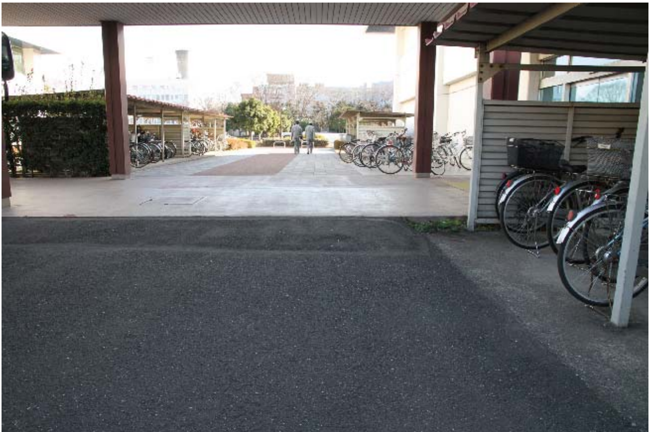
③⑦ 上り 傾斜 4.0° (段差解消部)
