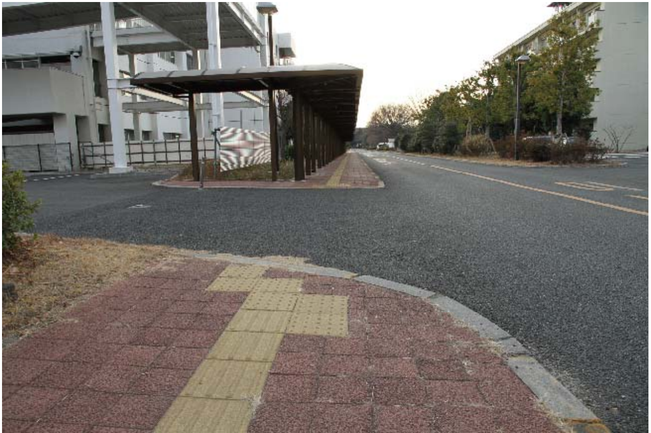
⑳ 歩道の切れ目 下り - 傾斜 1.5^{\circ} \sim 2.0^{\circ} 右 1.8^{\circ} \sim 3.5^{\circ} 段 1.5cm 上り - 傾斜 1.5^{\circ} \sim 5.5^{\circ} 右 3.5^{\circ} \sim 4.6^{\circ} 段 ほぼ無し
