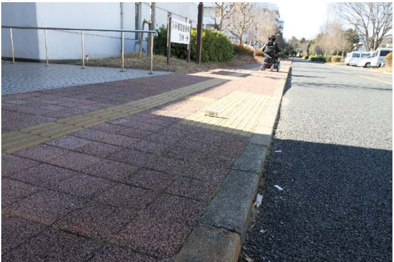
㉑ 歩道の切り下げ 右傾斜 4.2^{\circ} 下り傾斜 2.2^{\circ} 上り傾斜 3.2^{\circ}
