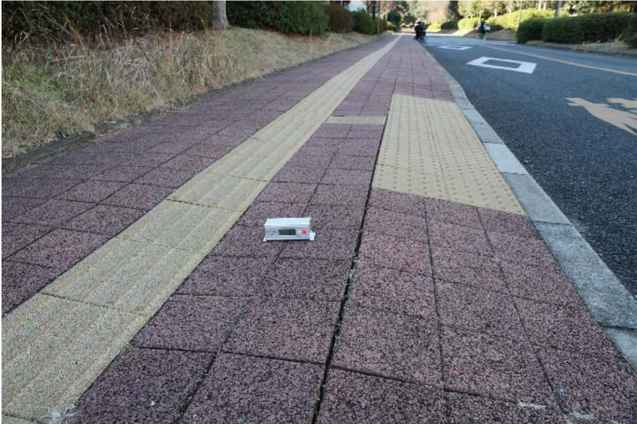
23 複雑な凹凸のある歩道(左傾斜 3.6^{\circ} )、切り下げ(右傾斜 7.9^{\circ} ) 下り 3.0^{\circ} 上り 3.7^{\circ}
