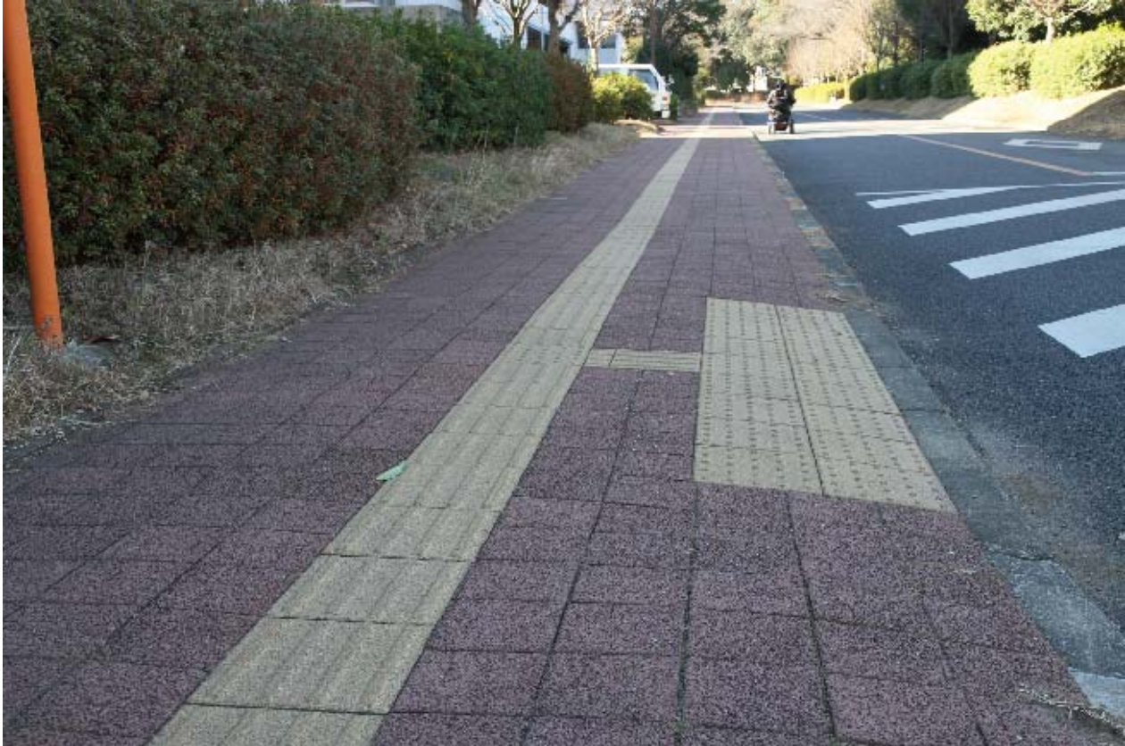
24 複雑な凹凸のある歩道(左傾斜 1.0^{\circ} )、切り下げ(右傾斜 6.0^{\circ} ) 下り 3.5^{\circ} 上り 2.2^{\circ}
