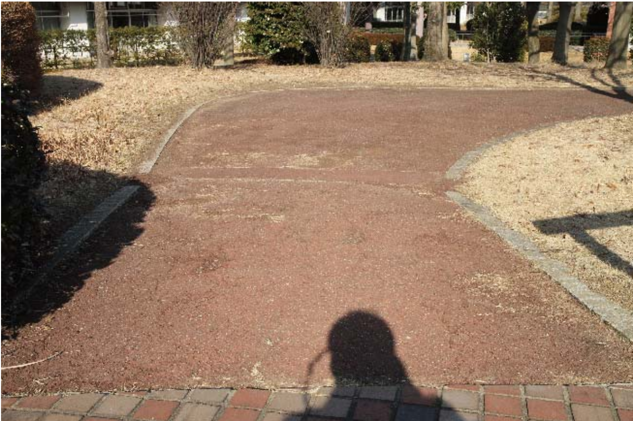
28 下り坂 最大傾斜 6.6°、凹凸の激しい路面、手前の路面からの段差 1.5 ~ 2.0cm
