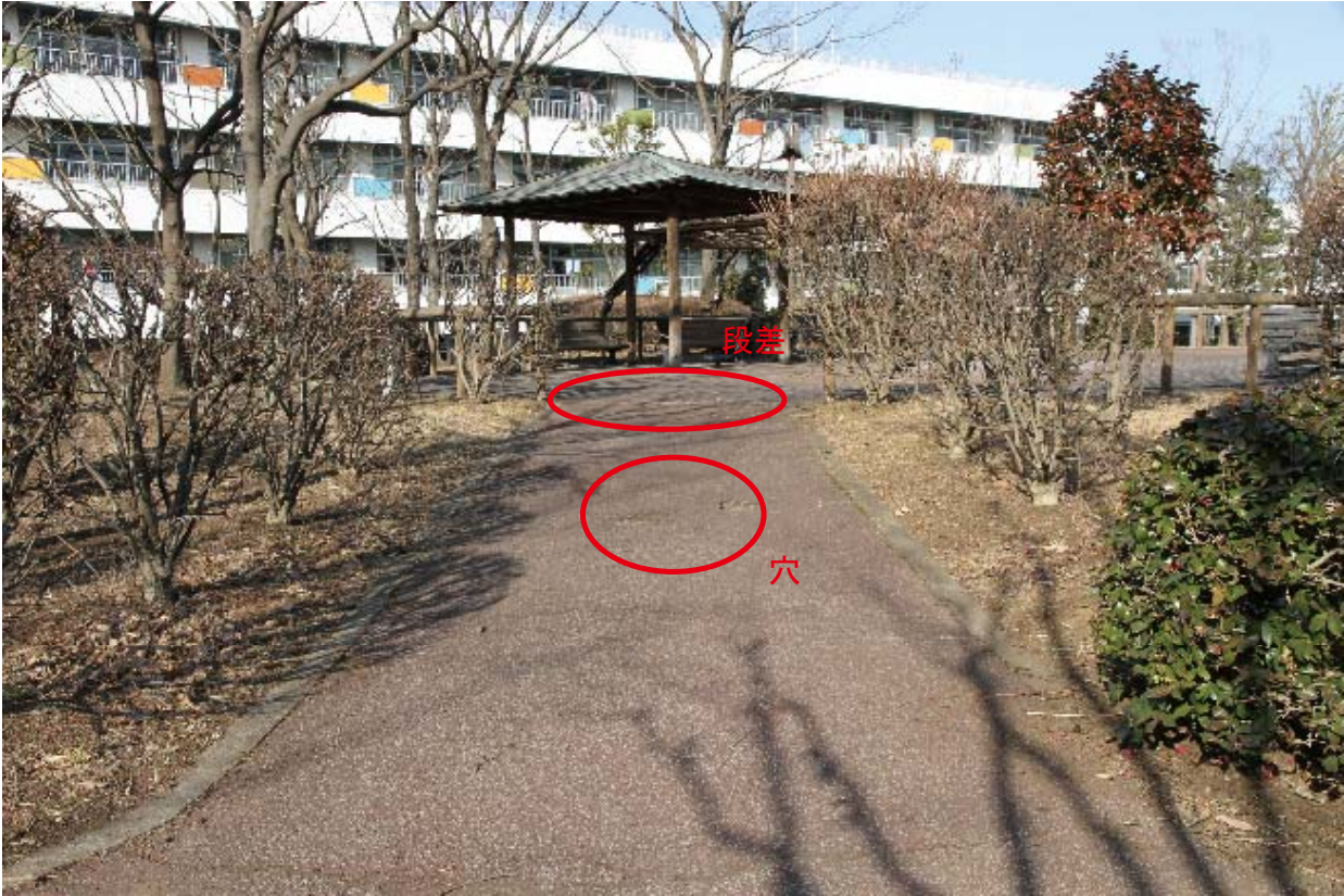
27 上り坂 最大傾斜 10.0°、歩道の穴 深さ 2.0~2.5cm、平地への移行部の段差 2.5 ~ 3.5cm
