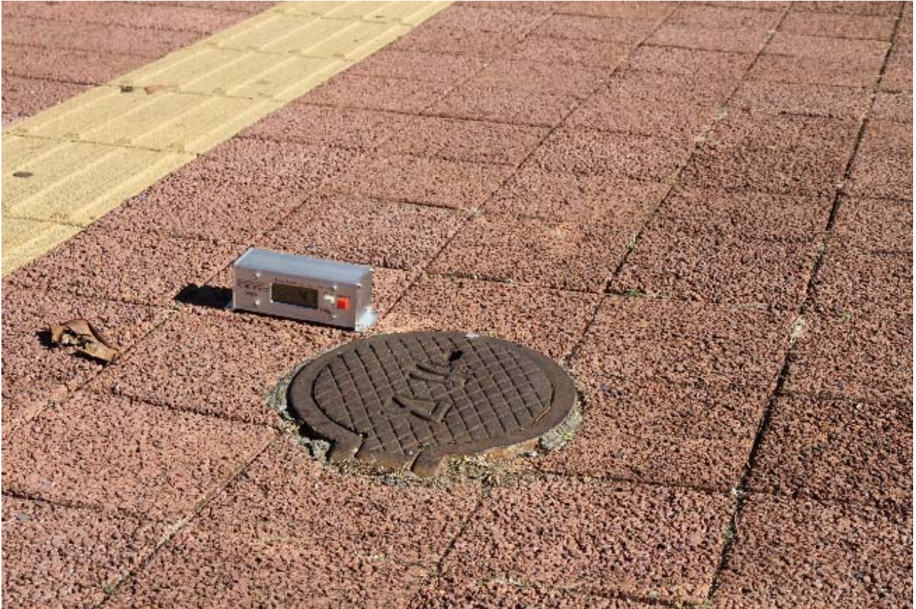
⑬ ガス点検口部凹凸 傾斜最大 4.7°
