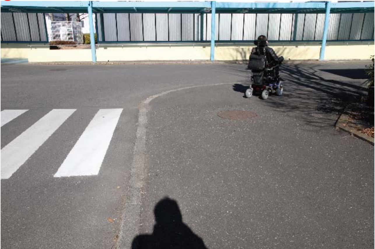
⑩ 左傾斜 2.3^{\circ} 、右カーブ、マンホール通過部 左傾斜 6.0^{\circ} の複合
