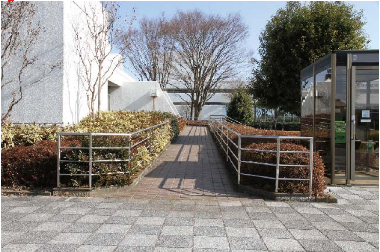
⑦ 講堂入口スロープ 上り坂 3.7° 横傾斜最大 0.5°
