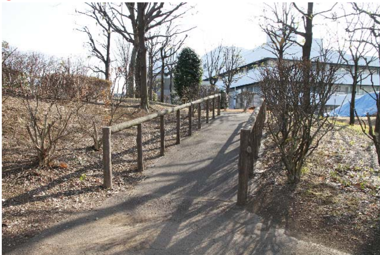
②⑥ 上り坂 最大傾斜 10.0^{\circ}
