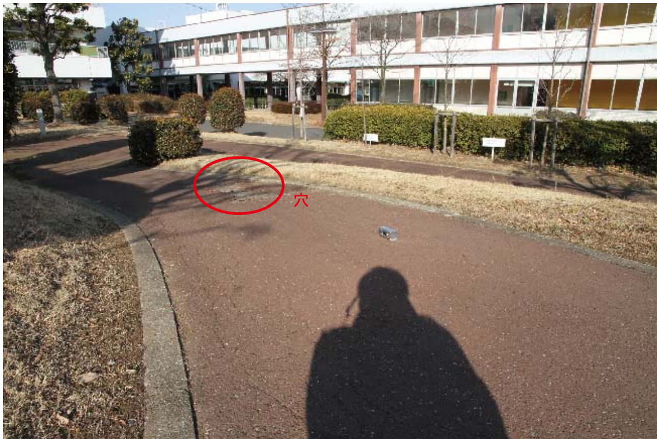
③⑩ 下り坂 最大傾斜 5.2^{\circ} 、右側に大きな陥没(陥没部は避けて通る)
