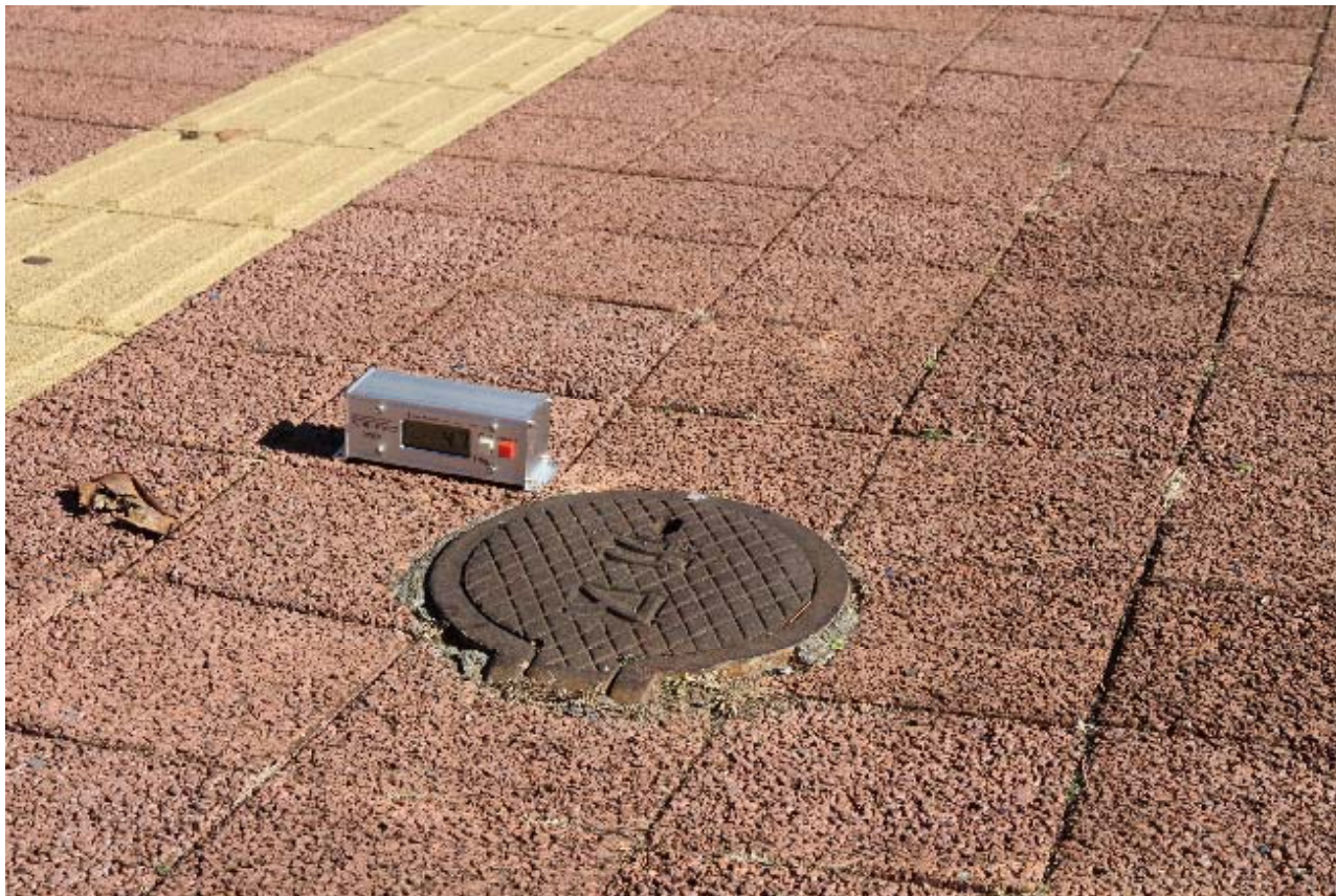
⑬ ガス点検口部凹凸 傾斜最大 4.7°
