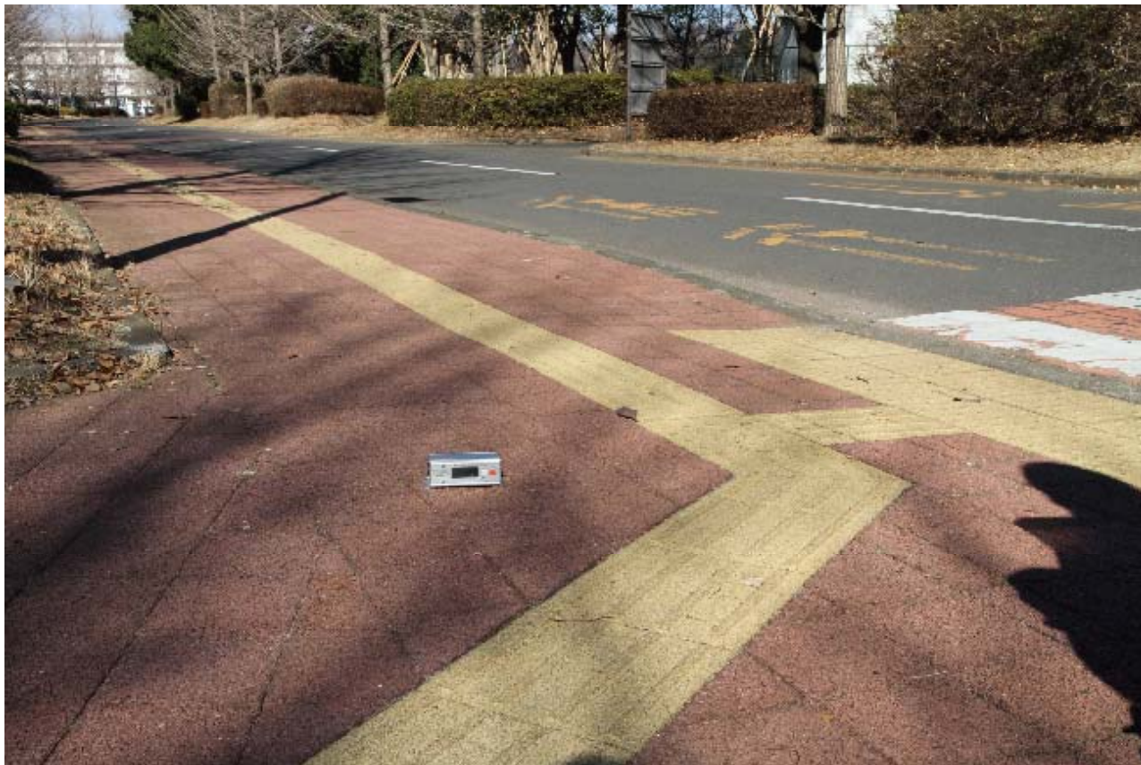
⑭ 右傾斜 1.6°、左折、点字ブロックの複合
