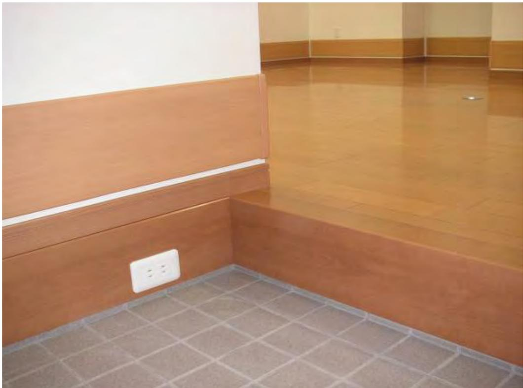
図II-6-44 玄関框に設置した段差解消機用電源
