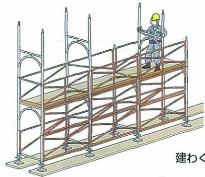
2層目手すり機材の組立て
