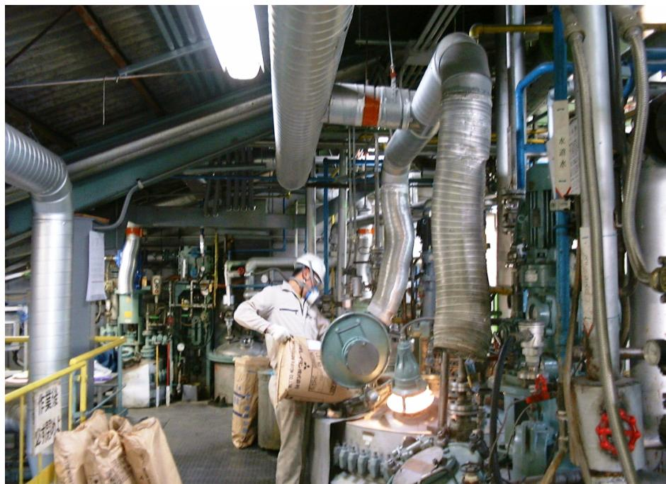
写真-2：局所排気ダクト（各リアクターの局所排気ダクト）
