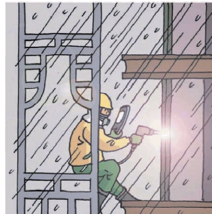
(高所でのアーク溶接)
