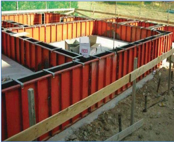
基礎きその中なかにアンカーボルトとホールダウンが埋め込まれています。アンカーボルトとは、一端をコンクリートなどに埋め込み、土台の基礎への緊結に用いるボルトです。ホールダウンも同様に地震などによって土台、柱が基礎から抜け落ちることを防ぎ、特に縦揺れに有効となる緊結金物です。アンカーボルト、ホールダウンとも太さ、長さ、形など様々なものがあります。
