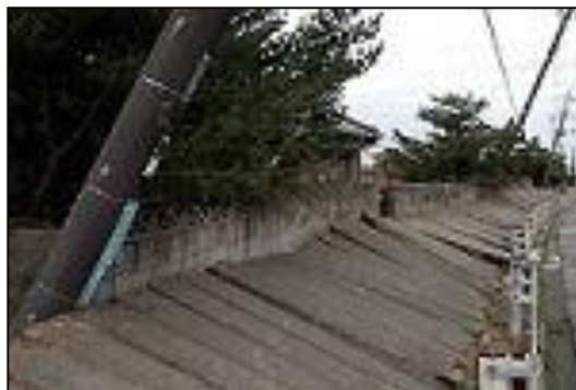
■潮来市（日の出地区） 町全体が地盤沈下し、アスファルトが波打って、電柱も傾いたまま。
