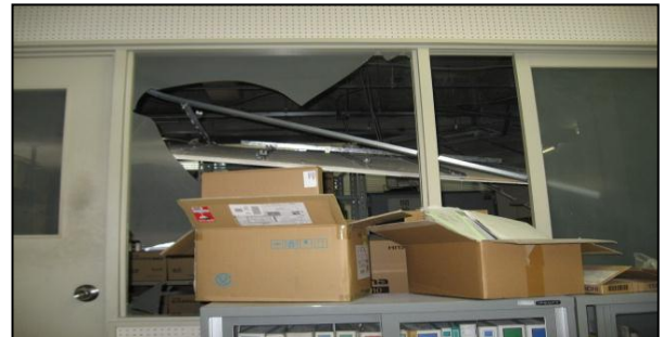
○日製日立総合病院（日立市） 複数病棟の使用停止、MRI等医療機器が損傷
