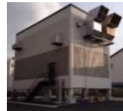
非常用自家発電設備のイメージ
