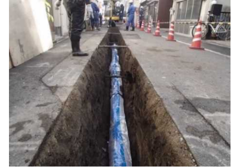
耐震管の布設イメージ
