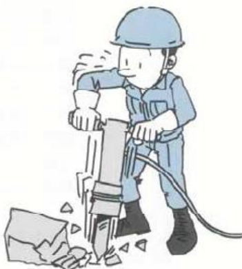
コンクリートブレーカーによる作業
