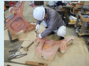
写真2： 木下地に合わせ鬼を打ち出している様子
