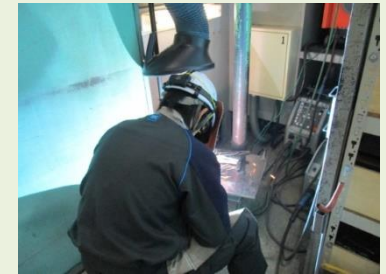
写真：アーク溶接作業の様子
