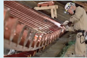
写真1： 屋根に銅板を葺いている様子
