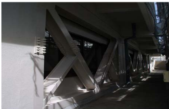
登戸地区研究本館耐震改修工事
