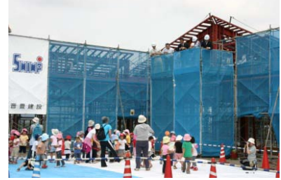
保育園の子供たちに建設中の建物を案内
