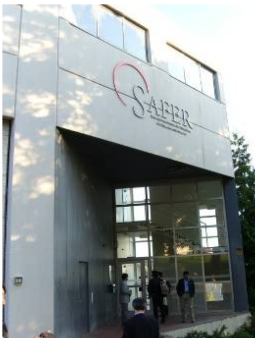
図 1 SAFER 施設外観
