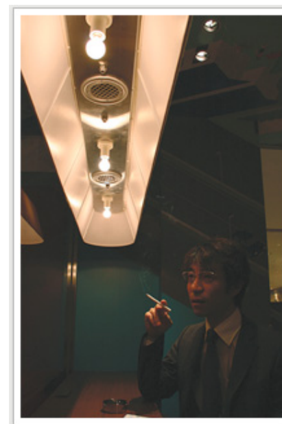
シェード内部に設けられた換気口が、立ち昇ってきた煙を集める。
