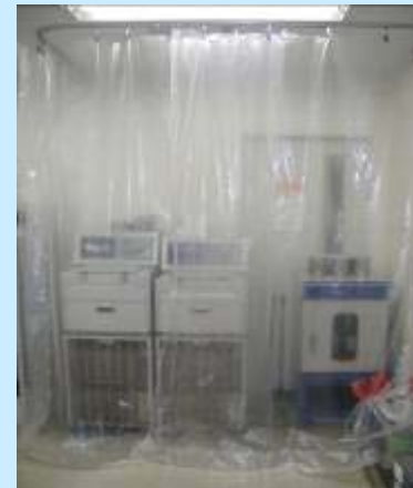
常時関与しない箇所の隔離
