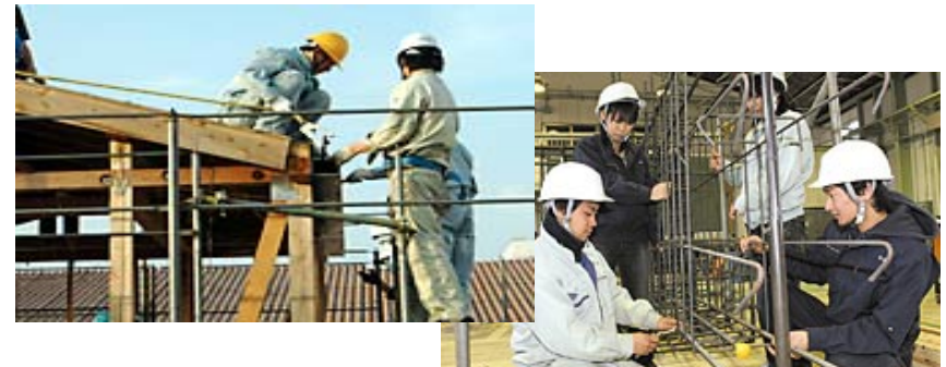
建築施工実習
