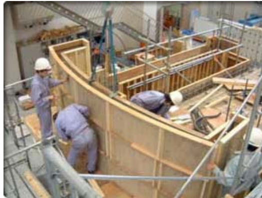
グループ別課題による、鉄筋コンクリートの施工実習
