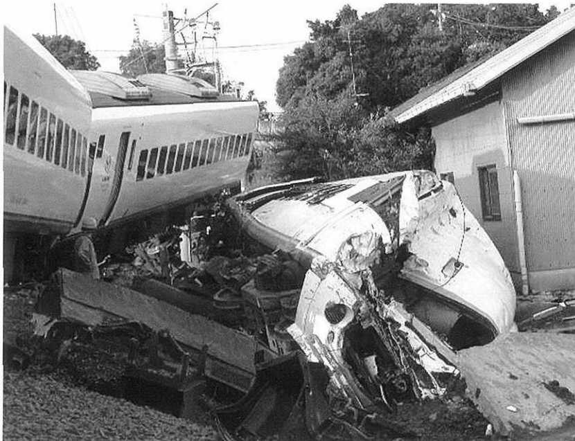
九州旅客鉄道長崎線列車脱線事故(平成15年7月18日発生)
