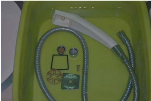
図2-2 シャワーヘッドの分解・清掃の例
