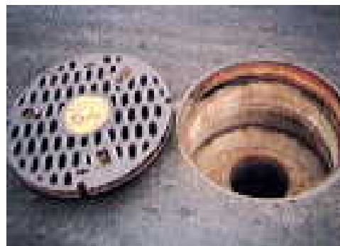
新設海水取水口
