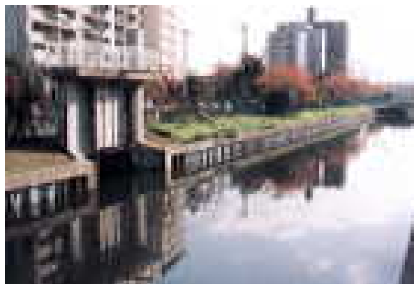
城門放流幹線水門
