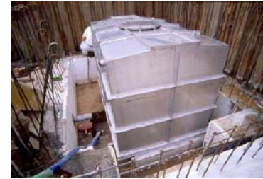
雨水貯留施設
