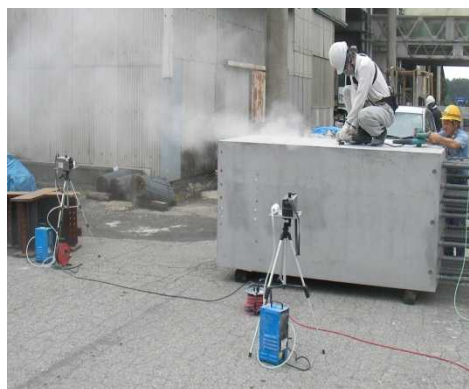
図 2.3 コンクリートに対する研磨・ばり取り作業の測定
