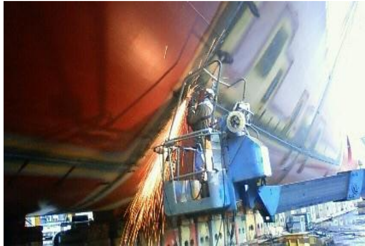
図 3.6 接合部における金属研磨作業の様子
