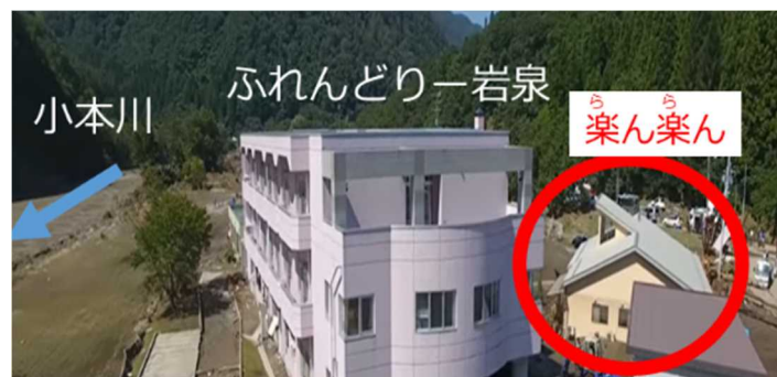
図 15 平成28年9月の岩手県岩泉町の洪水氾濫による災害の写真
