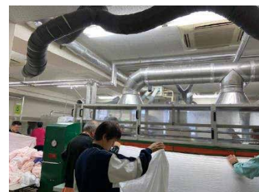
シーツローラー機で仕上げ作業
