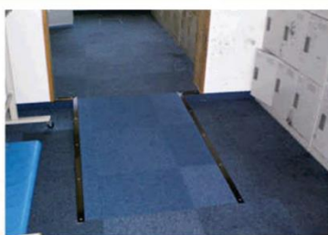
事例1：スロープの設置
