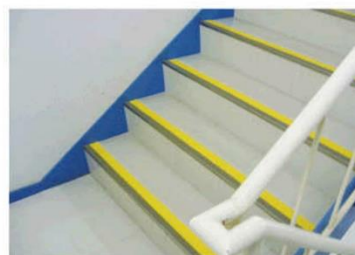
事例4：視覚障害者が認識しやすいように階段にテープを貼る
