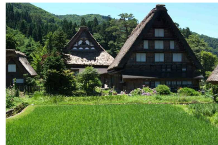
合掌造りの屋根下地
