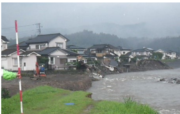
河岸侵食による家屋の倒壊(花月川)
