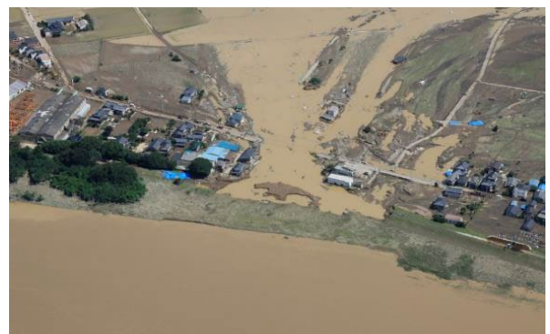
堤防決壊による家屋の流失(鬼怒川)
