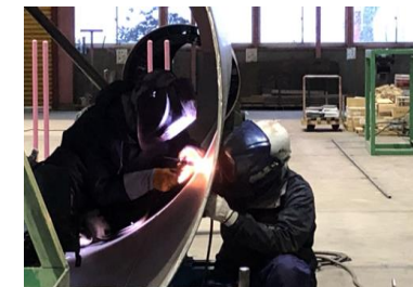
写真：溶接作業
